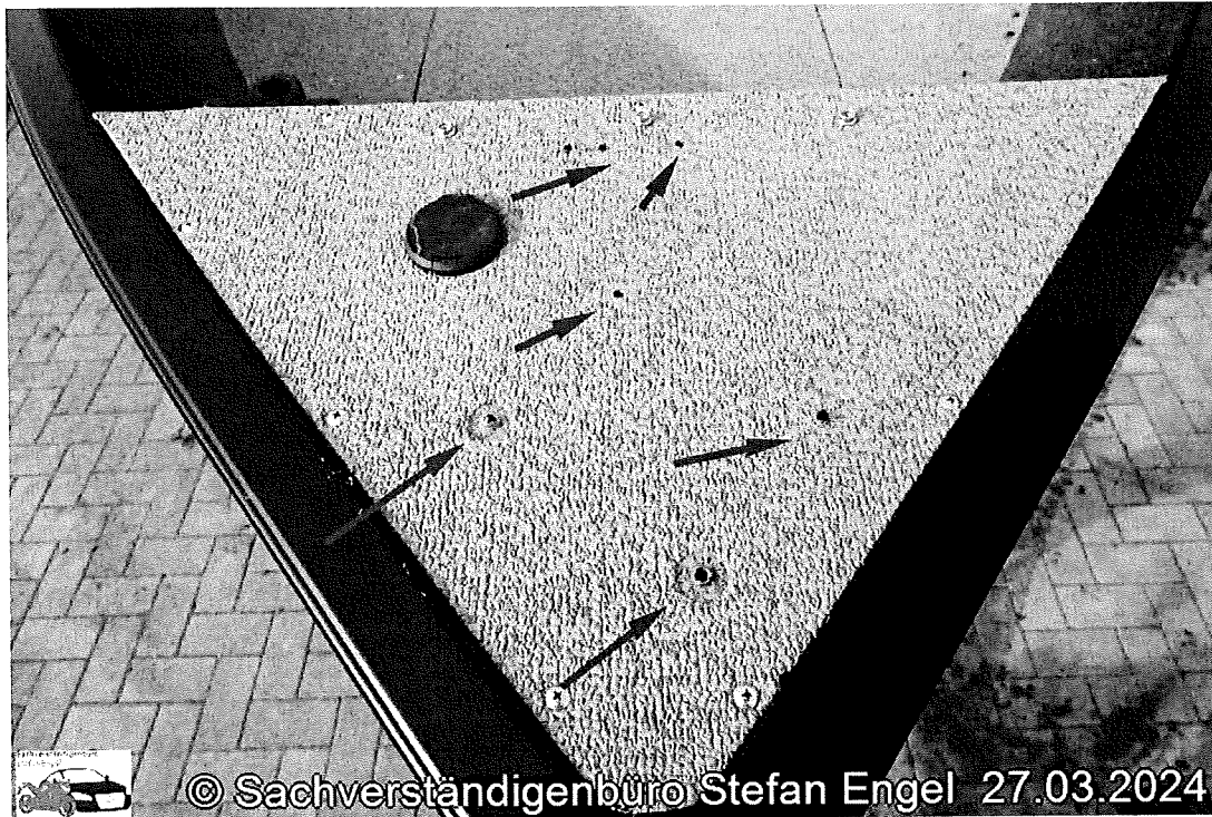
Foto 17: zusätzliche Bohrlöcher
