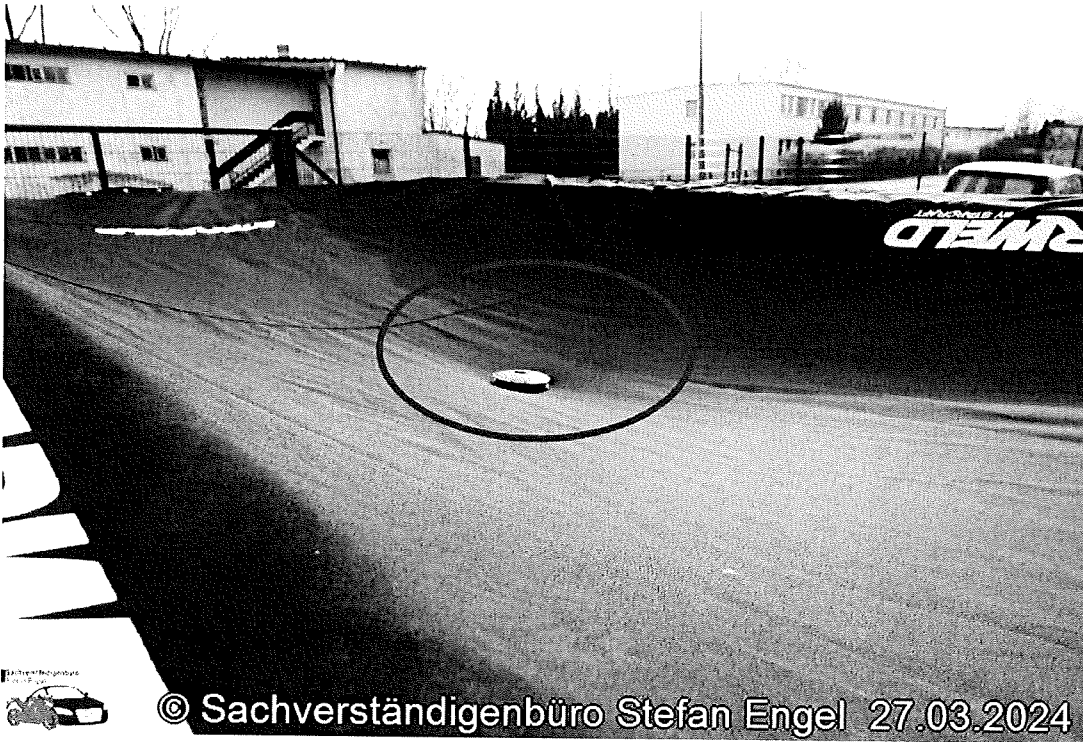
Foto 11: nicht vorhandener Ständer der Persenning
