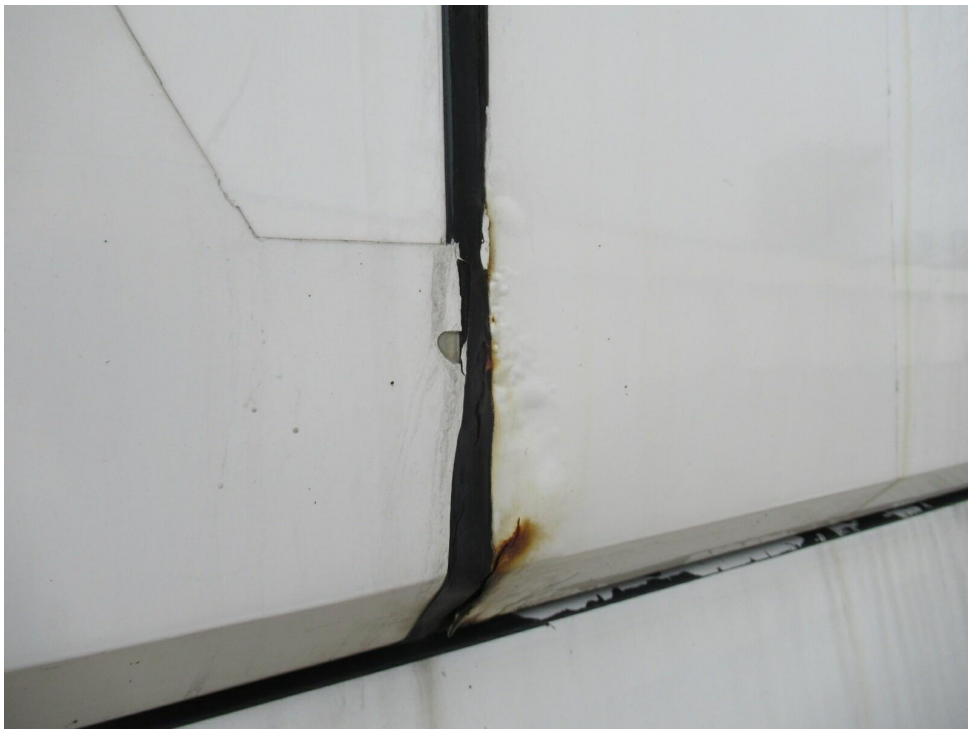
Bild 18 : Korrosion an der Beplankung links
