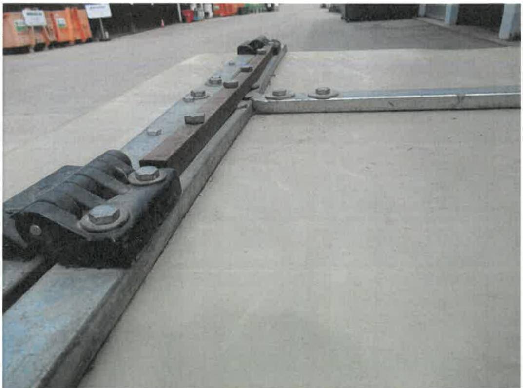
Bild 23 : Fangbox hinten Vierkantrohr instandgesetzt
