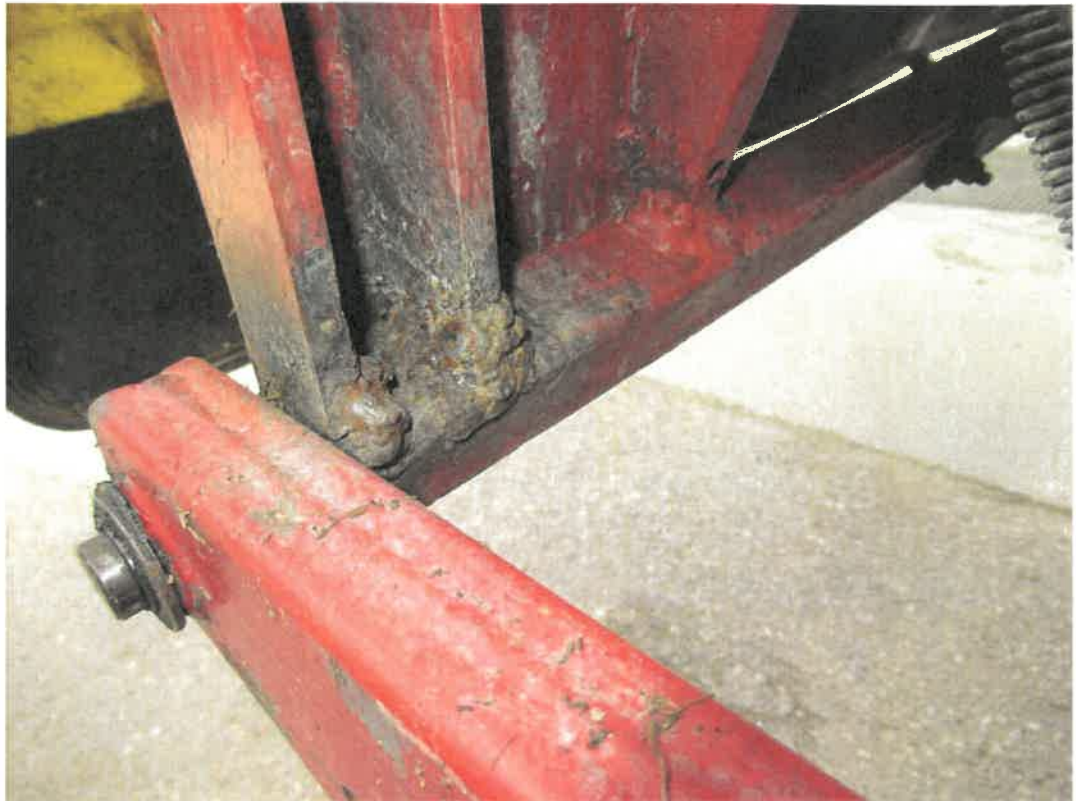
Bild 17 : Hochentleerung Rahmen mehrmals Reparaturschweißungen
