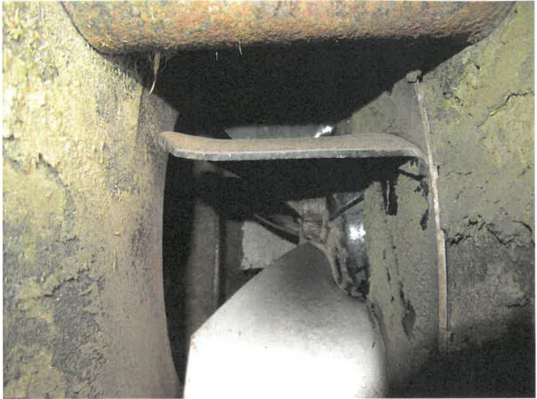
Bild 13 : Zustand Verschleiß der Windschaufeln
