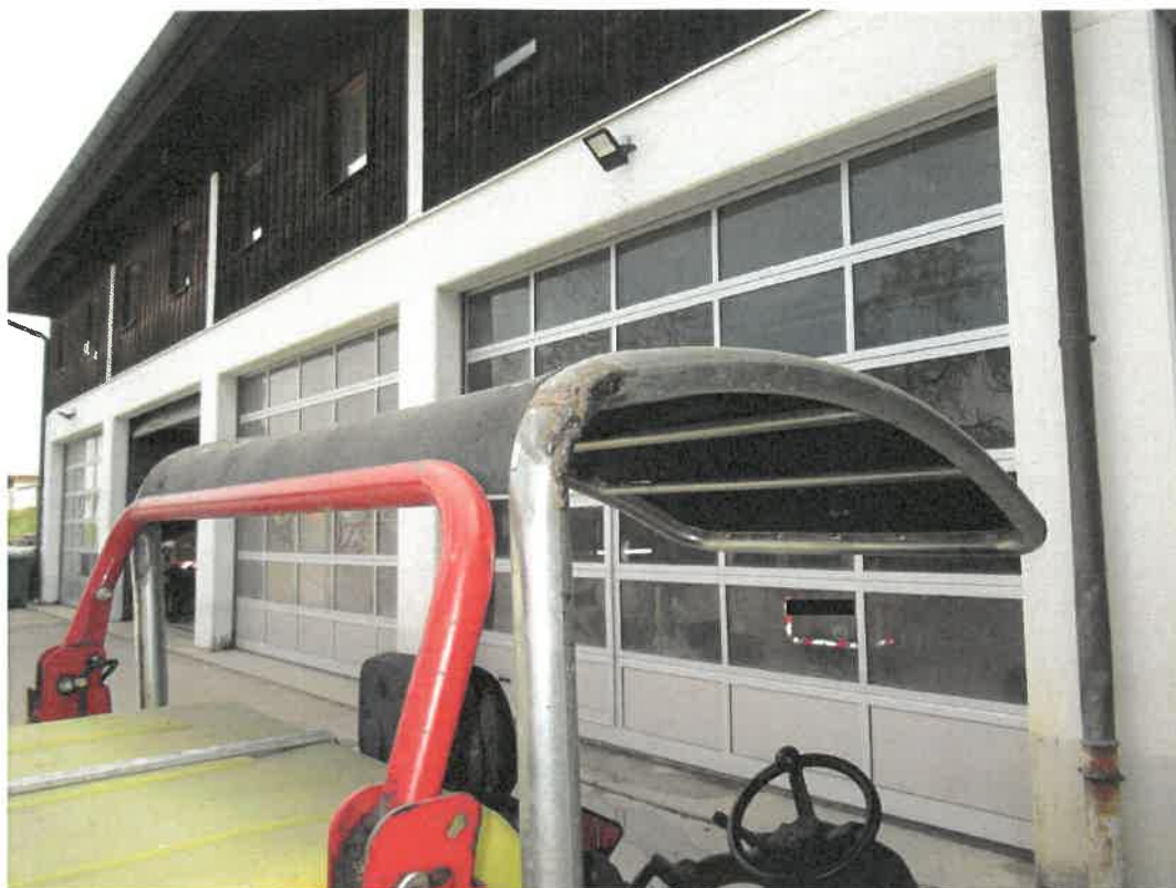
Bild 26 : Sonnenschutzdach mehrmals Halter eingerissen und geschweißt
