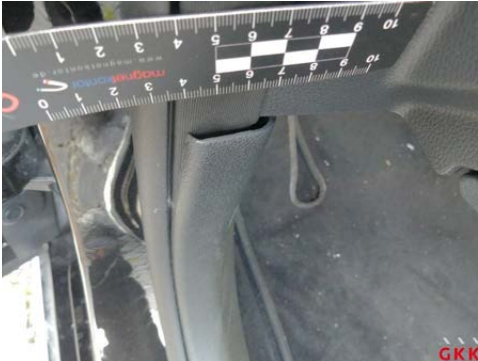
Bild 21 A- Säule links, Innenverkleidung -unterhalb-, beschädigt, ersetzen
